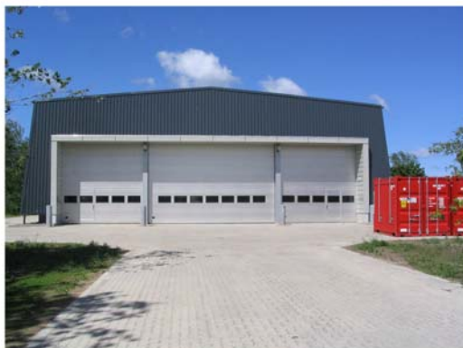
DD's nybyggede mellemlager til dekommissioneringsaffald
