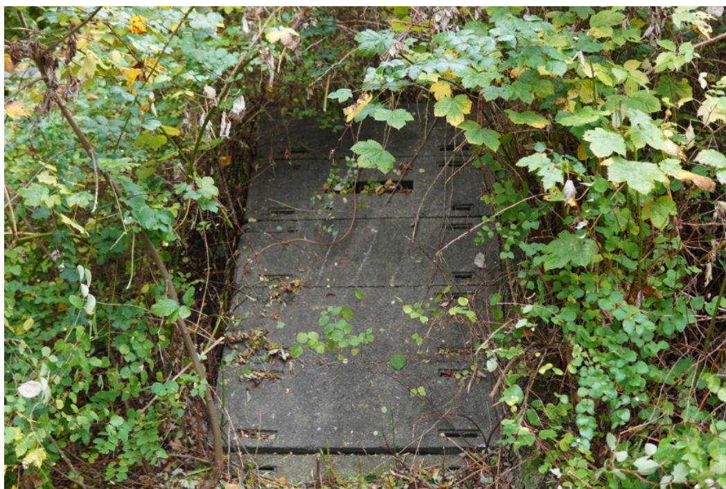
Figur 1 Eksempel på indgang til en betondækningsgrav. Her er indgangen lukket af med betonplader.
