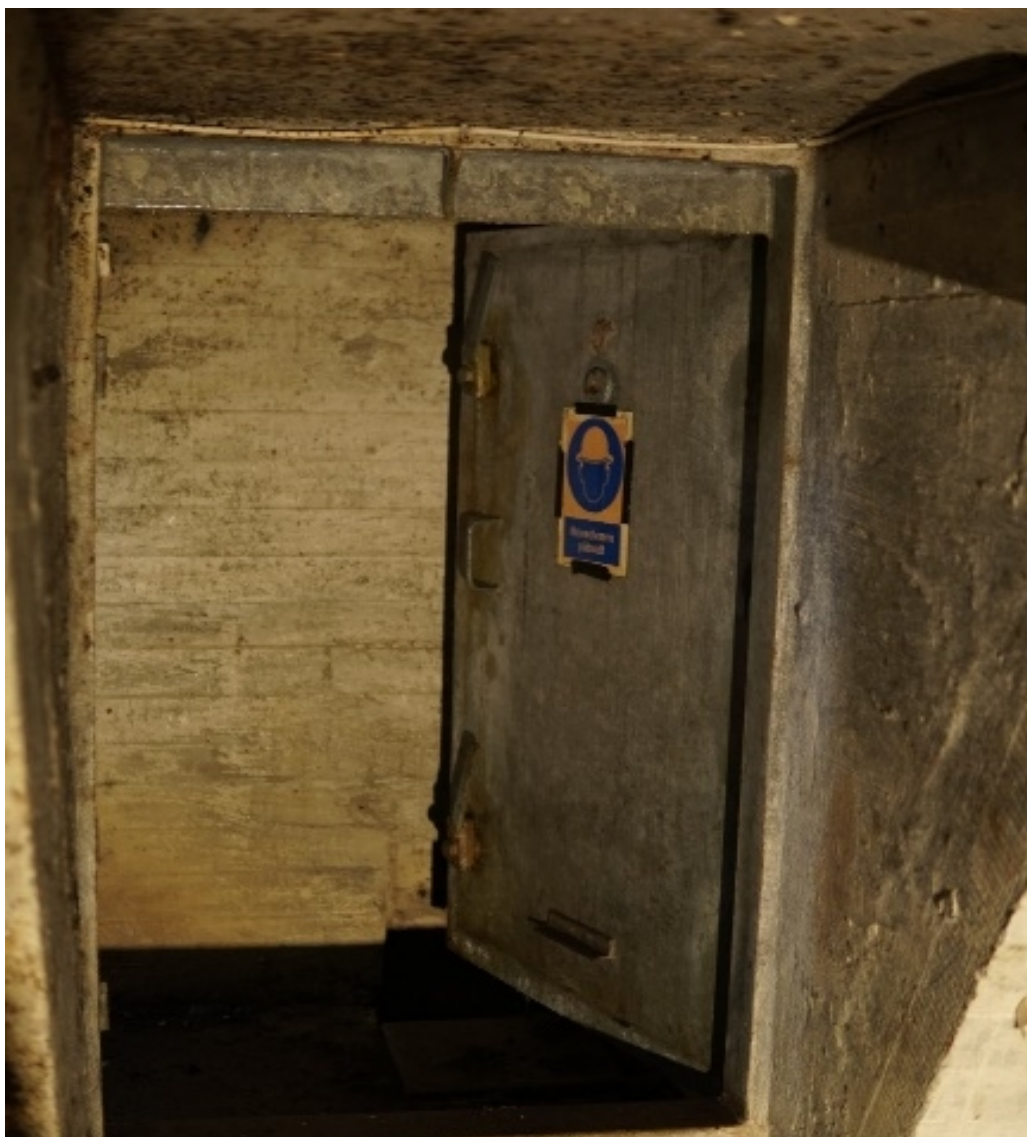
Figur 2 Eksempel på synlige tegn på skimmelsvamp (sorte plamager over adgangsdoor)
