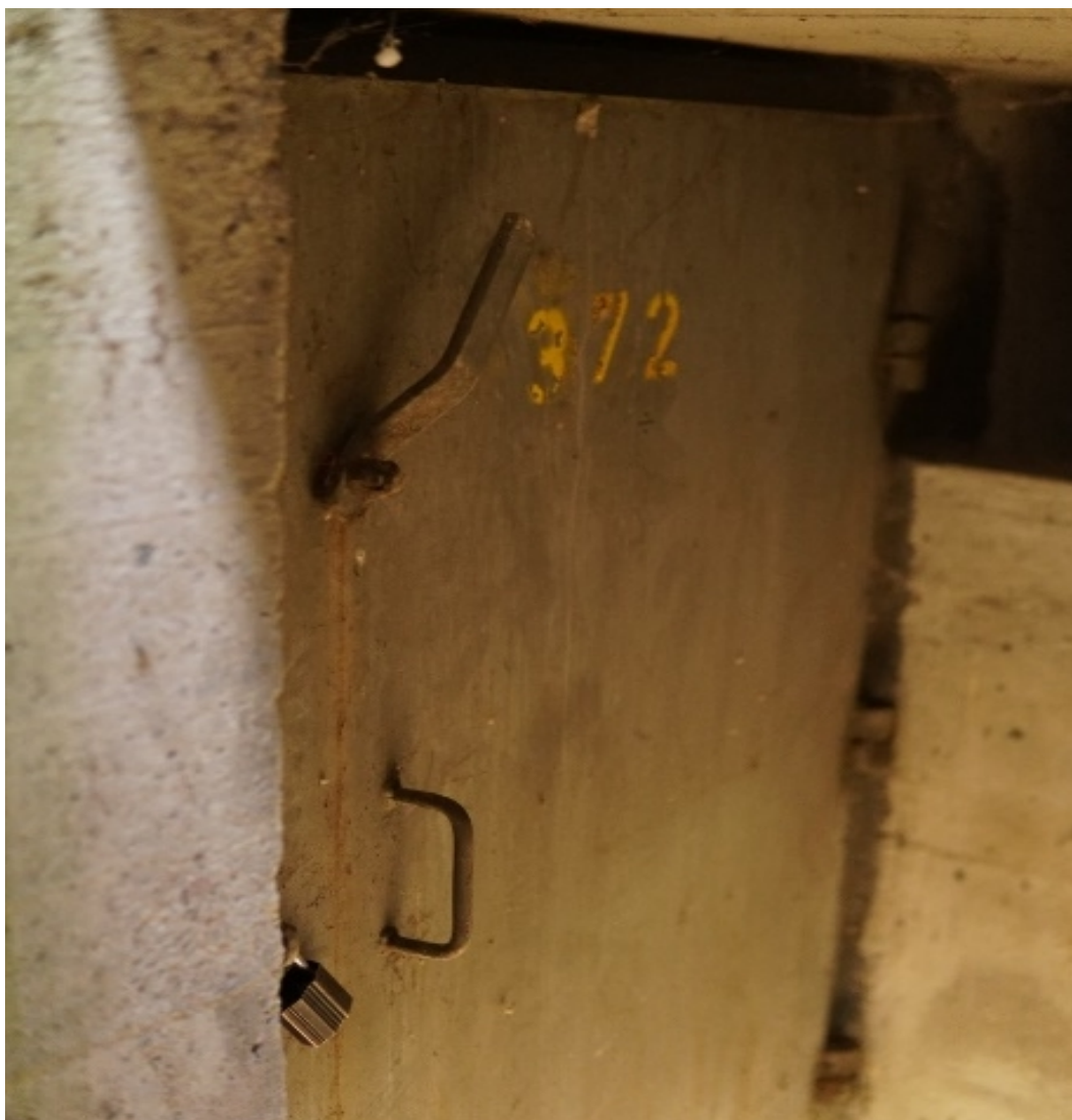
Figur 4 Ståldør, adgangshul/dørhul til indre opholdsrum (set fra trapperum)
